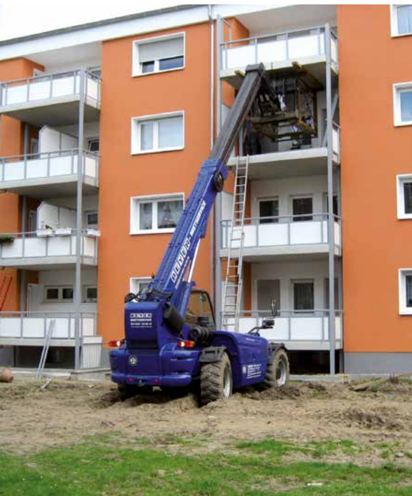
Schließlich gelang das Anheben der neuen Balkone
